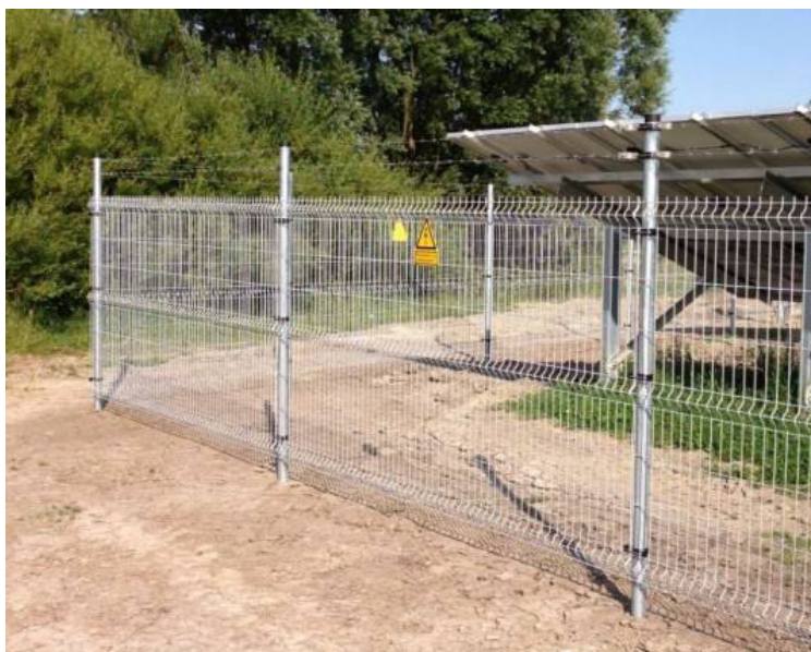
Abb. 12: Beispiel einer Zaunanlage 2,5 m Höhe inklusive Übersteigschutz
