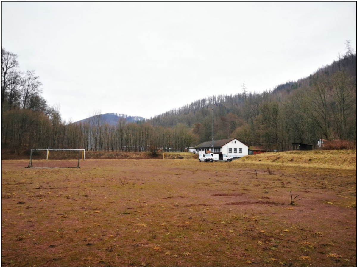
Blick auf die Baufläche (Grandplatz) Richtung Norden
